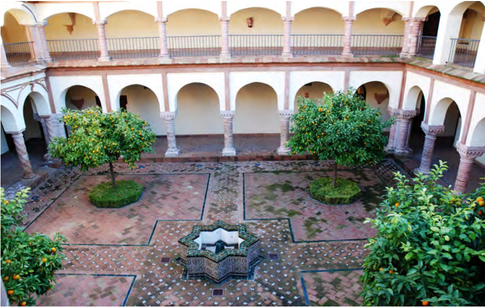
El claustro del convento de Santa Clara es una construcción donde predomina la arquitectura mudéjar con columnas de ladrillo cerámico y capiteles mocárabes. (Foto Rafael Morales)
